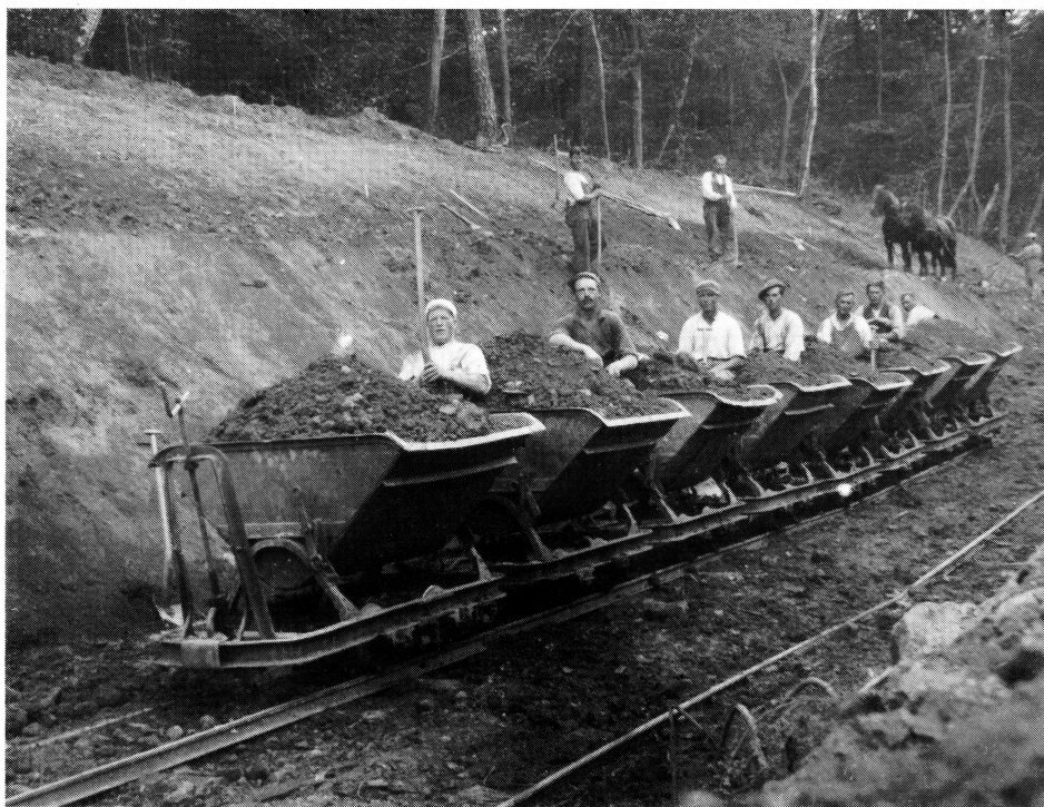
Der blev hentet jord i skoven til opbygningen af vejdamningen over åen. Vognene blev trukket op og fyldt med jord, hvorefter de selv kunne løbe ned til vejbyggeriet.
