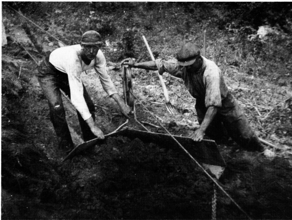
To arbejdsmænd ved en jordskuffe, der godt kunne være et effektivt redskab, trukket af en petroleumsmotor med et wirespil, men her var jorden for ujævn.
