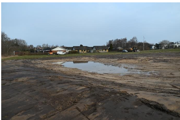
Dam 1 – nordligst i skoven
