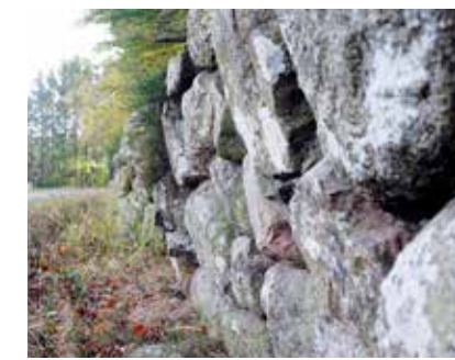
Fig. 3. Fastings ydre gærde, der fik et overfald på tre tommers. Sigtemøllevej i Aaker.
