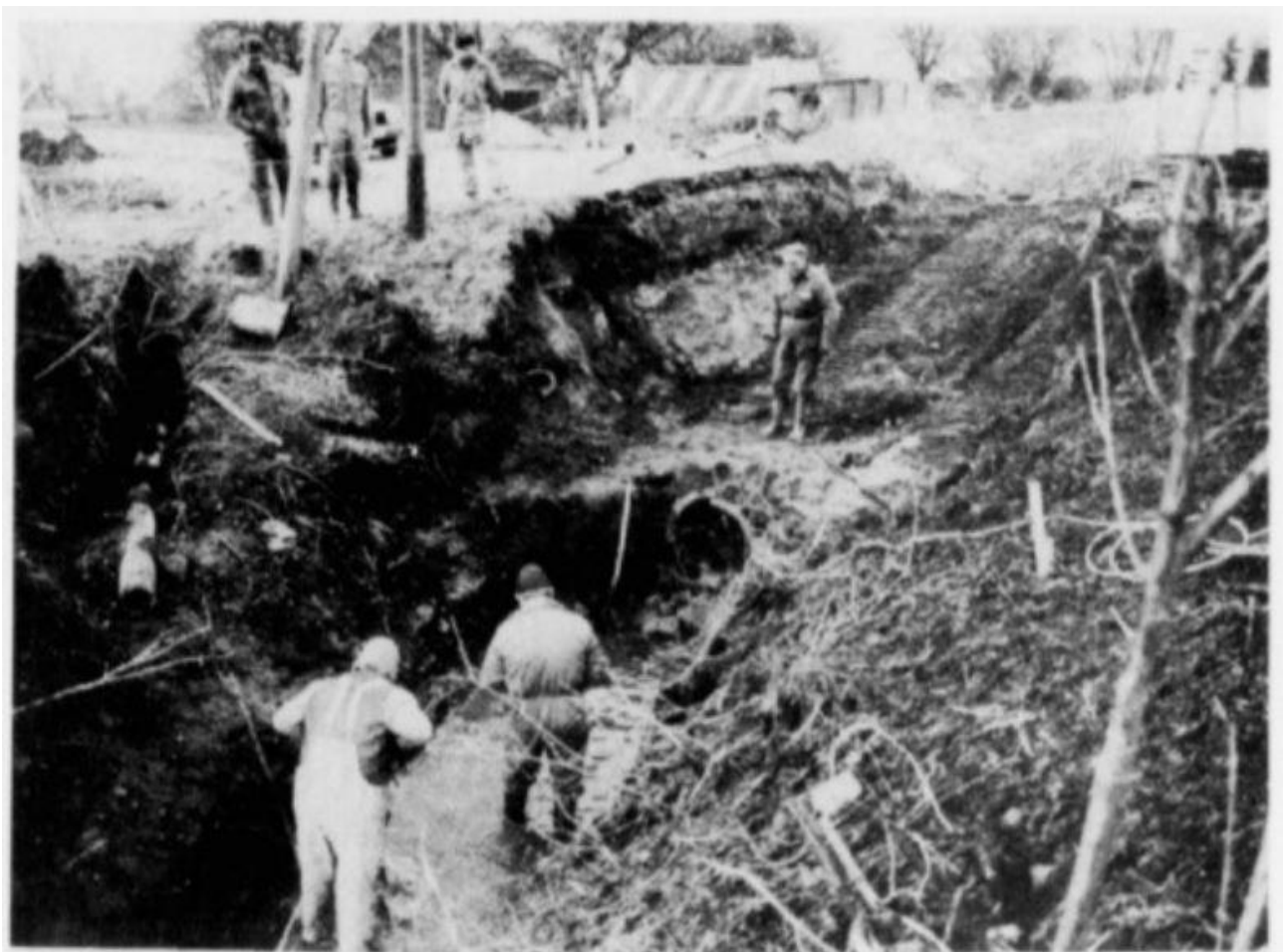
Vejbroen over Risebæk er gravet op, og der sprænges i selve Risebæks løb for at få den gjort dybere.
