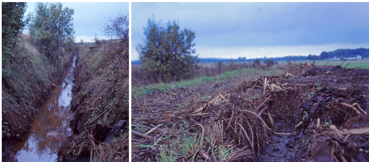
Oprensning af Risebæk-grøft september 1999. Fortsat okkerforurenet 15 år efter uddybning
