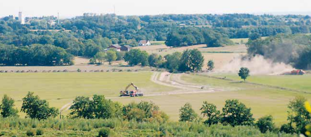
Fig. 7. Gravemaskinen graver den tidligere Læsågrøft medens en lastbil og en dumpers kører jorden i depot
