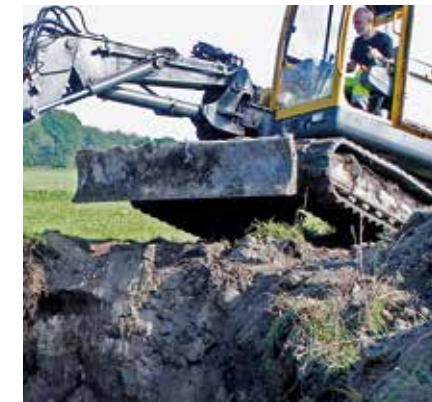
Fig. 8. Den lokale entreprenør Benny Andersen smadrer en samlebrønd for at vandet kan holdes tilbage i drænrørene i Vallenskæret og ikke løbe videre til Læsågrøften
