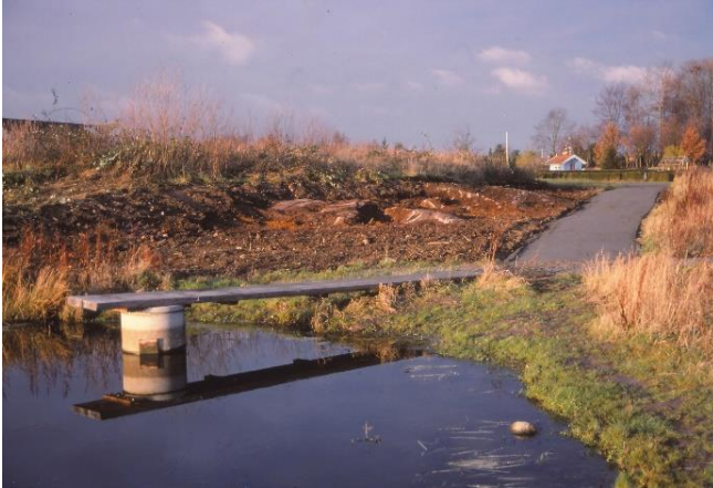
7. dec. 2001 – anlæg af sti og fritgravning af klipper
