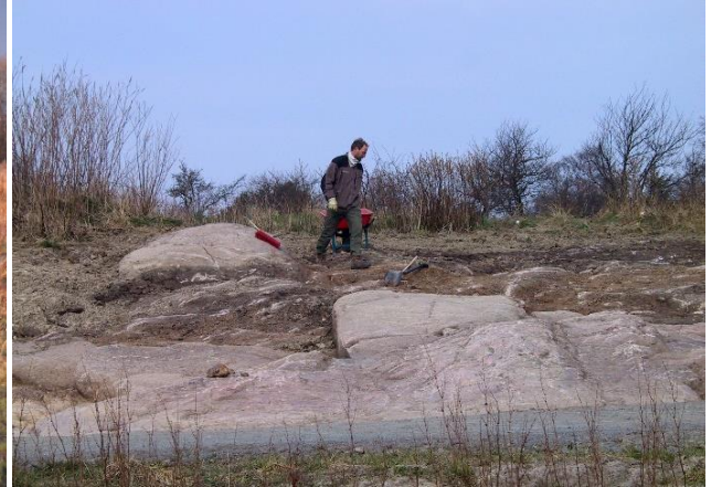
11. april 2002 – med spade, skovl, hakke, kost og trillebør
