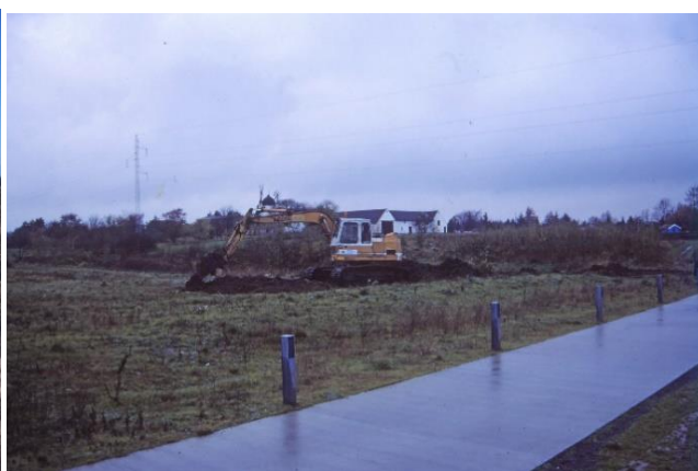
Oprensning af Bavnet-dam november 2000
