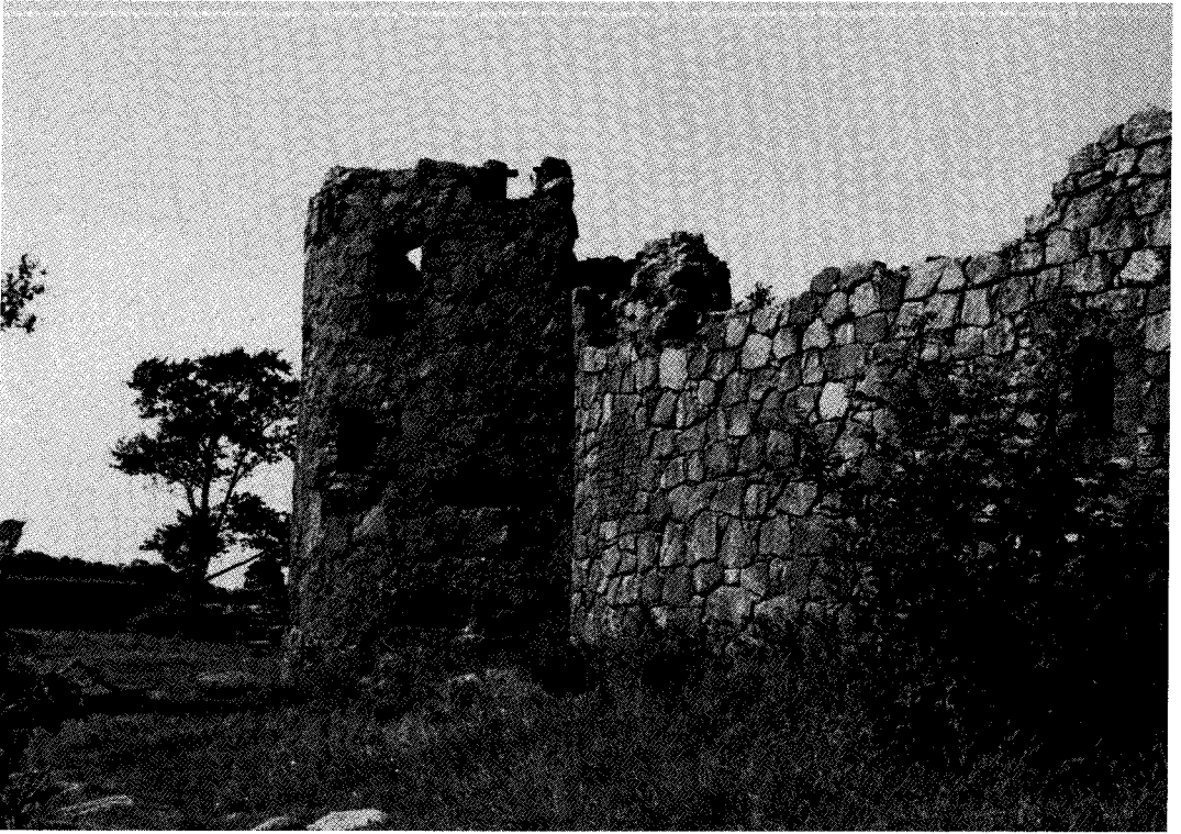
Fig. 5 Indre borg set udefra. Den gamle ringmurs nedre dele er bygget af granit som på det store tårn. Der har været krenellering på murtinden og én eller anden form for skyttegang. Foto: Bornholms Museum.
