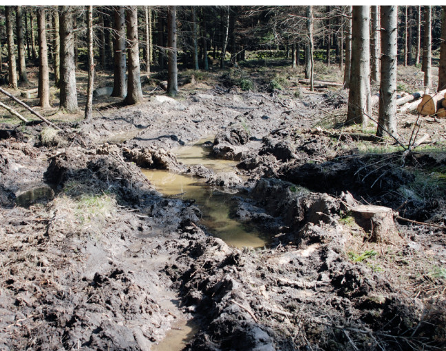
Fig. 10. Overkørt grøft på Springbakken efter oprydning af stormfældede rødgraner, grøft nr. 6, med dybe vandfyldte kørespor forår og efterår 2014.
