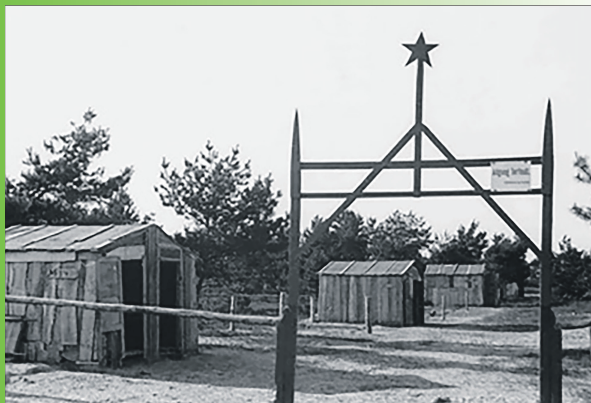
12 Russerlejren ved Levka efter at russerne havde forladt den i april 1946.
