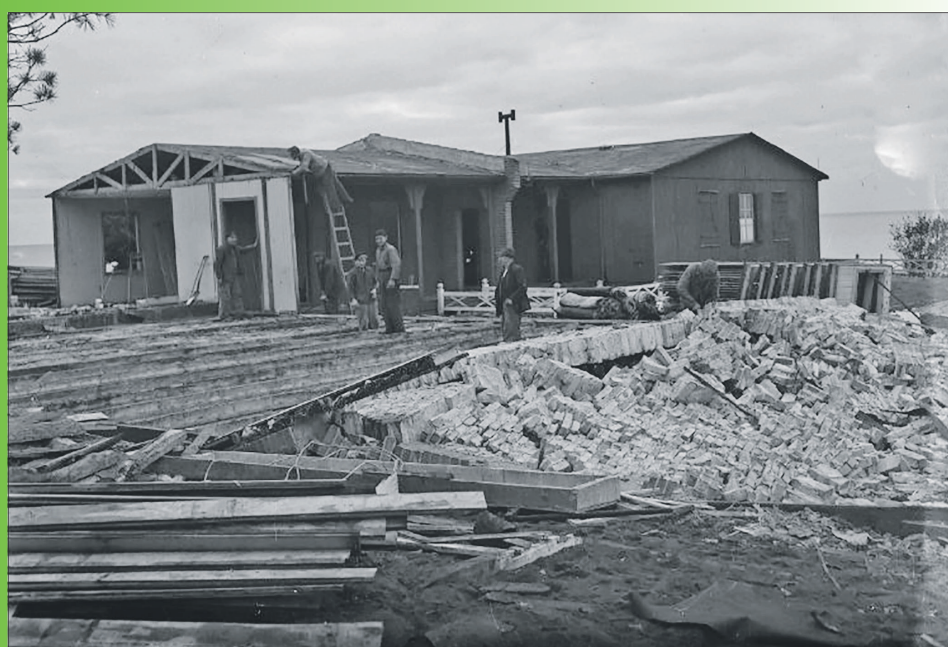
14 Nedrivning/flytning af støjmålerstation til Hasle.
