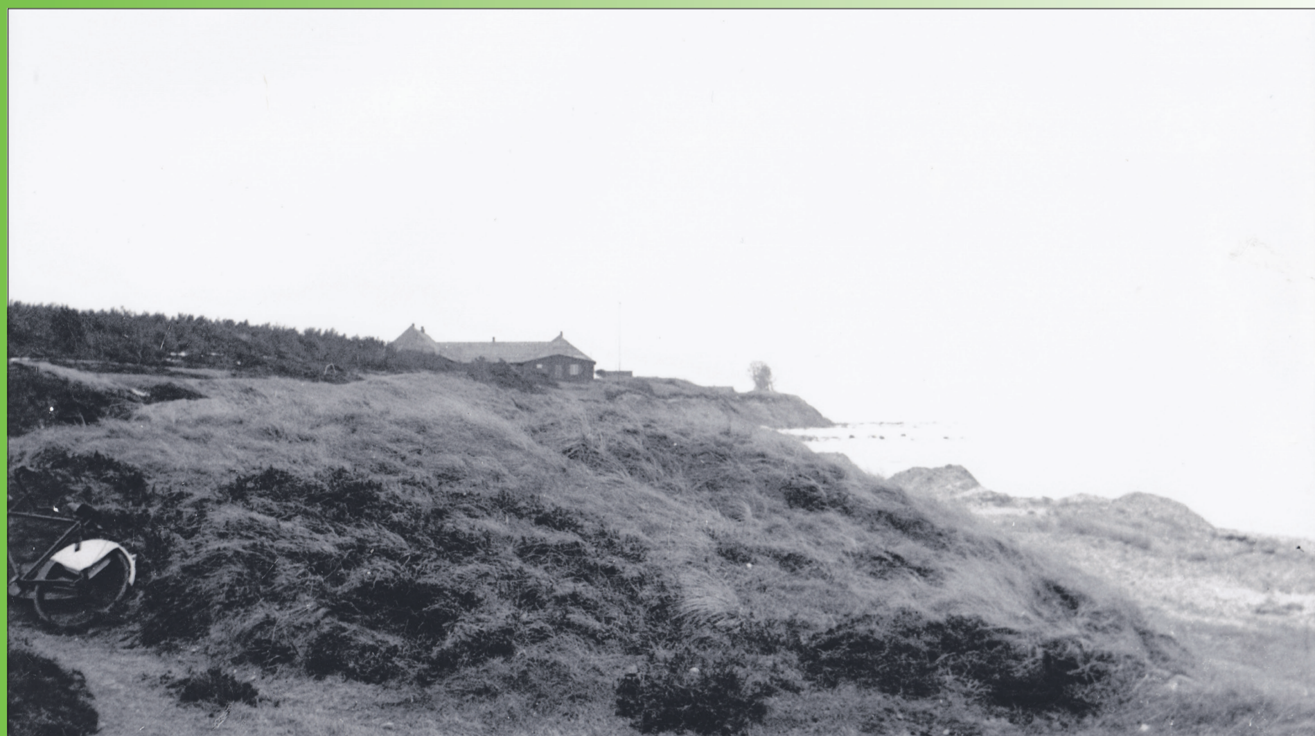
4 Levka Ubådsstøjmålerstation set fra nord.
