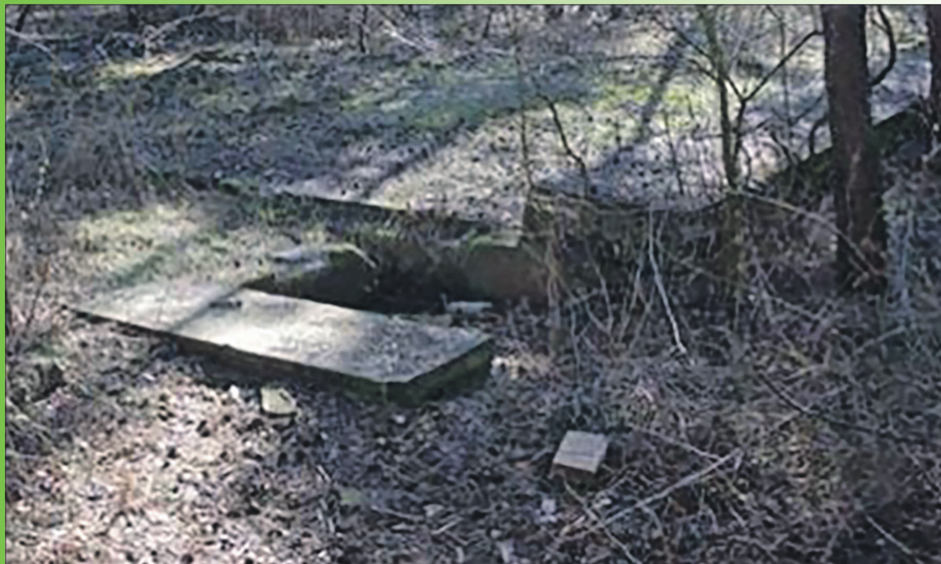
18 Fundamenter og betongulve 2017.
